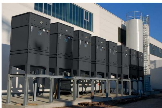
Varios módulos del ZPF en una serie con potencia de aspiración y superficie de filtración aumentada
