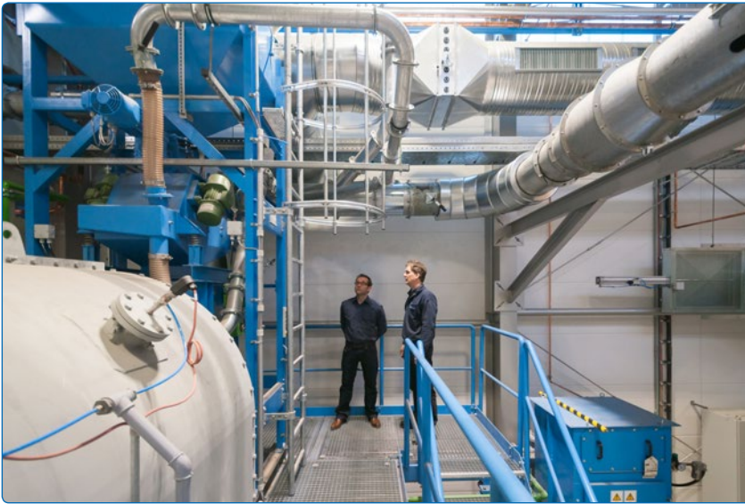
Die schadstoffhaltige Luft wird über zahlreiche Absaugstellen zur Filteranlage geführt wird.
