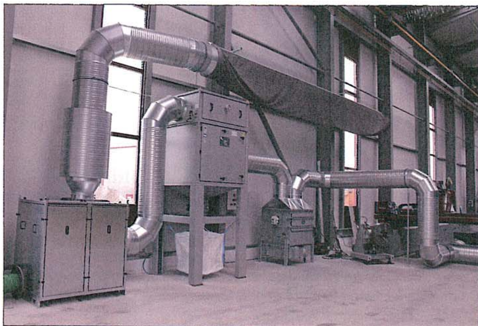
Die Absaug- und Filteranlage ZPF nimmt die schadstoffhaltige Luft auf und reinigt sie.
