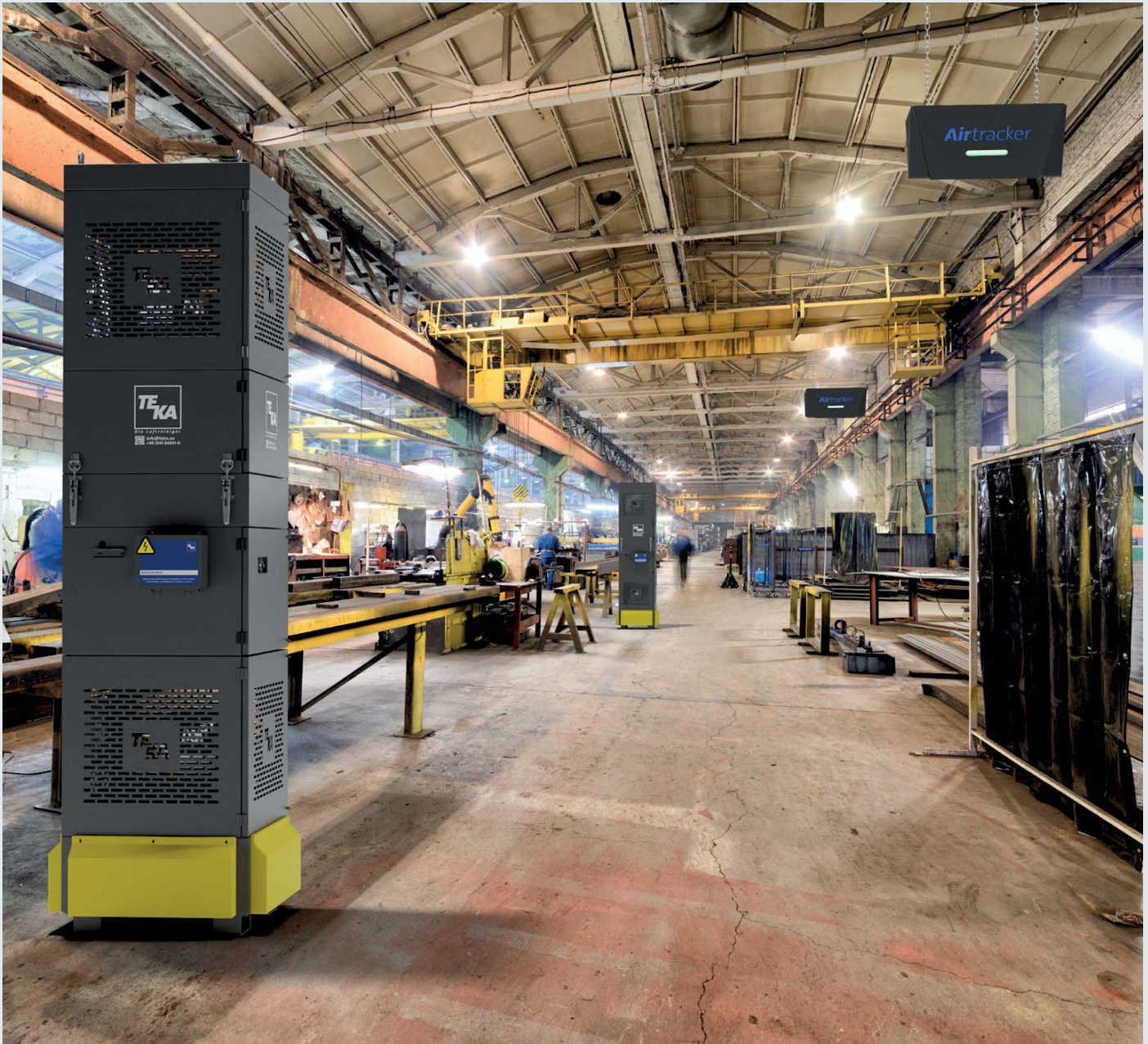
Exemple d'application CleanAirCubes avec Airtrackers
