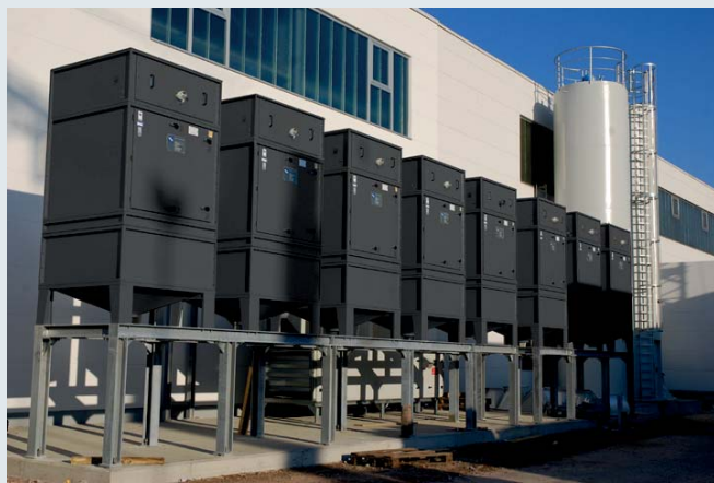
ZPF mit nebenstehendem Ventilator im Schalldämmgehäuse
